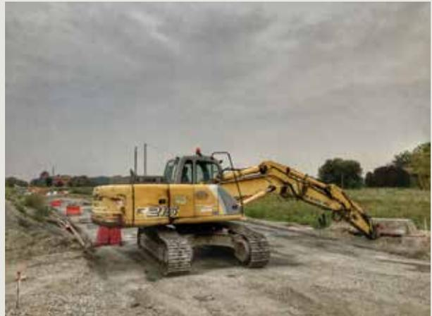
Stanno terminando i lavori per la costruzione del nuovo tratto di via Edera compreso tra l'incrocio con via Battisti e via del Moro. E' stata realizzata tutta la fondazione stradale che si sta completando con la pavimentazione in conglomerato bituminoso e il tappeto d'usura.
