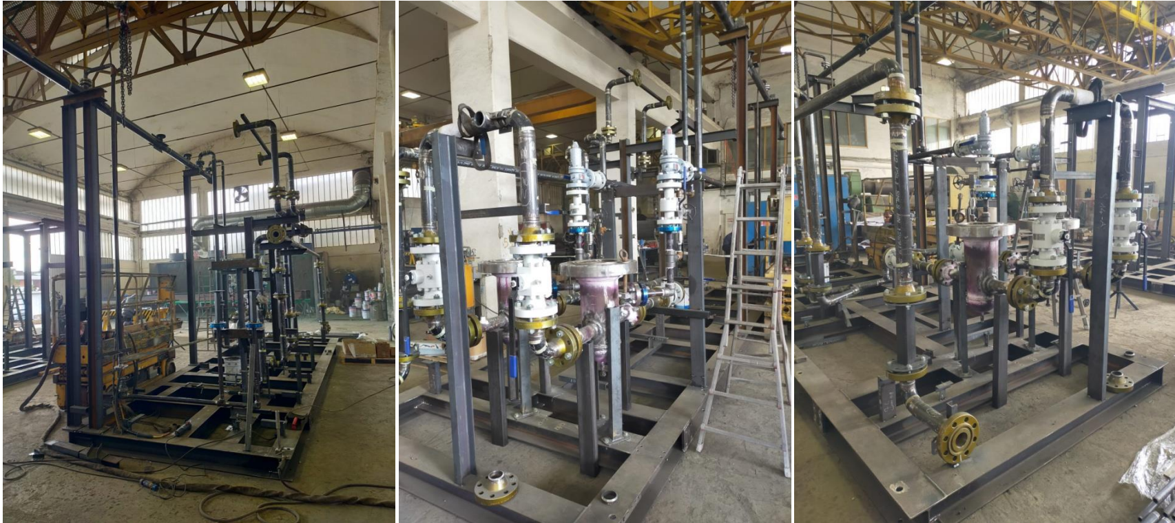
Montaggio apparecchiature disidratazione
