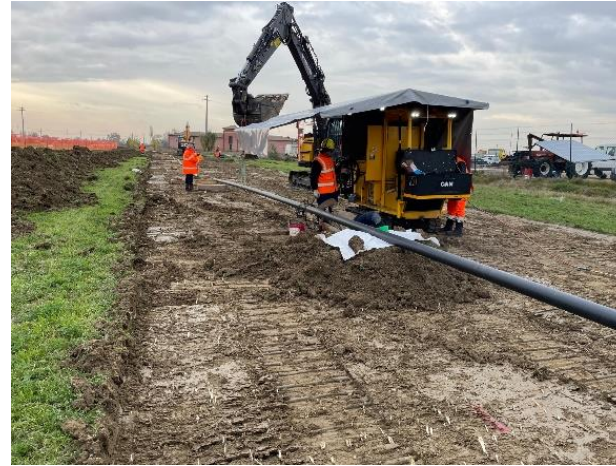
Saldatura tubi
