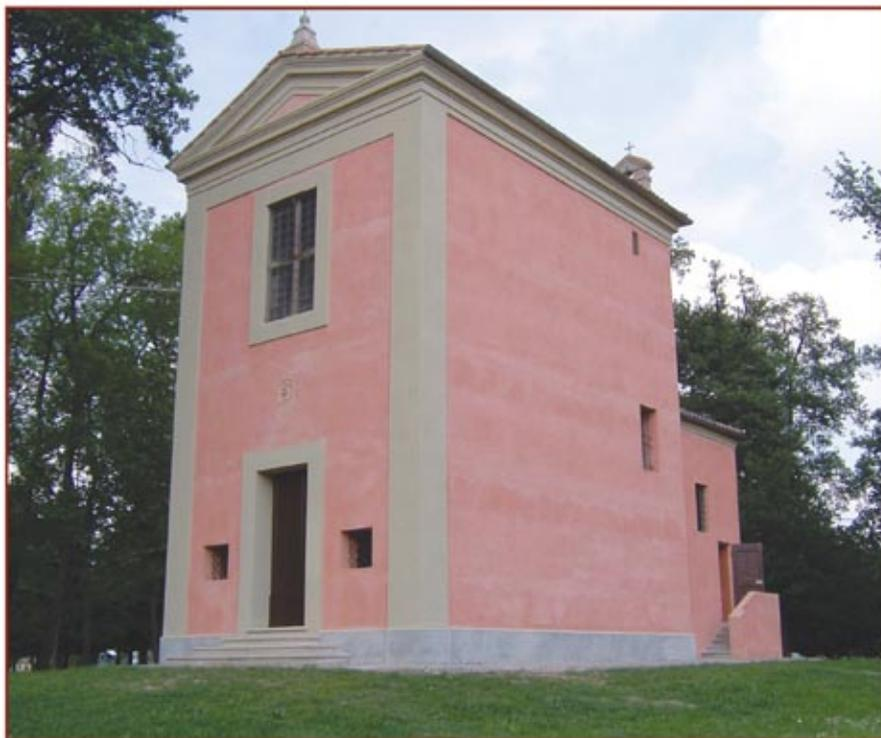
eseguiti hanno riguardato le pareti esterne, con il recupero degli intonaci ammalorati e delle tinteggiature, il restauro degli infissi, delle cornici in arenaria e dell'elegante paleotto in cotto posto sopra all'ingresso principale. Nell'interno sono stati eseguiti approfonditi interventi di pulizia delle superfici murarie e delle panche. Durante i lavori sono state reperite informazioni utili per collocare i processi storici vissuti dal fabbricato,
