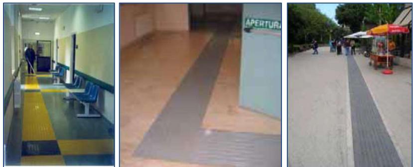
Figura 45, figura 46, Figura 47- Esempi di Segnali tattilo plantari
