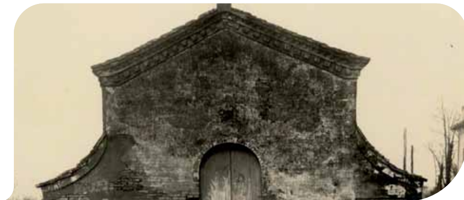
Facciata dell'oratorio di Santa Giuliana nel 1937 (prop. Parrocchia dei Santi Gervasio e Protasio della Pieve di Budrio)
