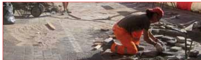
Lavori pubblici in via Bissolati
