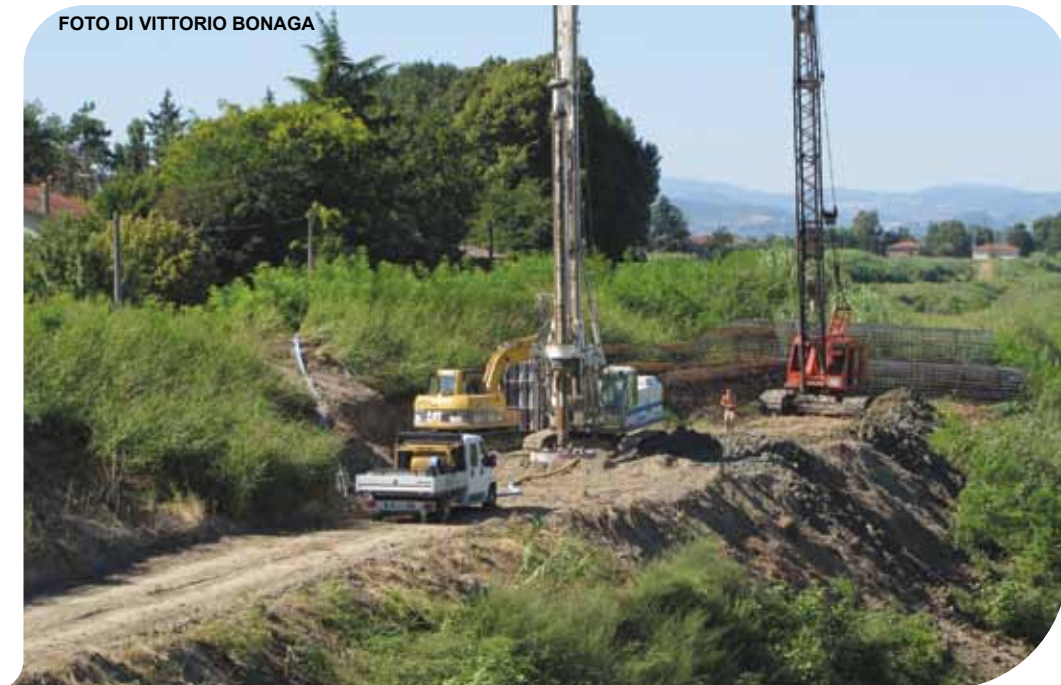
I lavori della trasversale di pianura alla Riccardina
