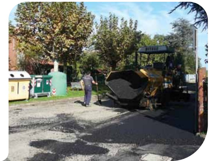
I lavori in via Tomasini
