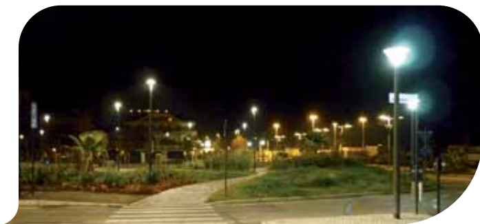
Un esempio della nuova illuminazione
