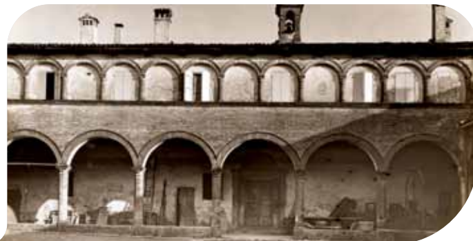
Cortile interno del Palazzo Bentivoglio nella prima metà del '900 (prop. archivio privato)
