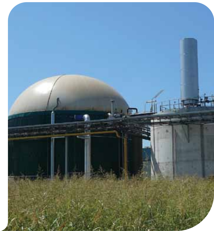
L'impianto di biogas della Pizzoli di Budrio che funziona con scarti vegetali da produzione industriale
